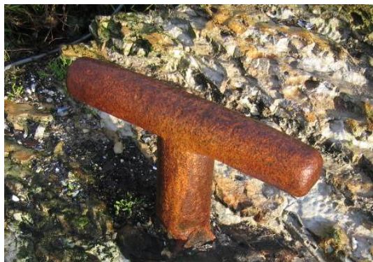
Solid fortøyningsbolt på Langøya, til akterfortøyning?
