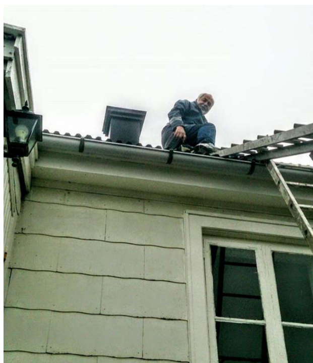
Svein Erik har reparert pipehatt
