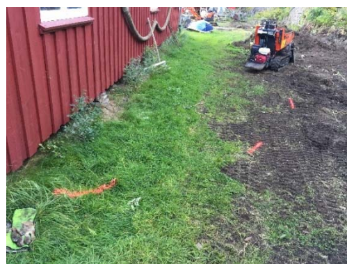
Merking av strømkabel med stiplede linjer
