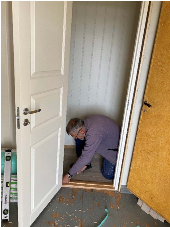
Atle i gang med å montere ny dør
