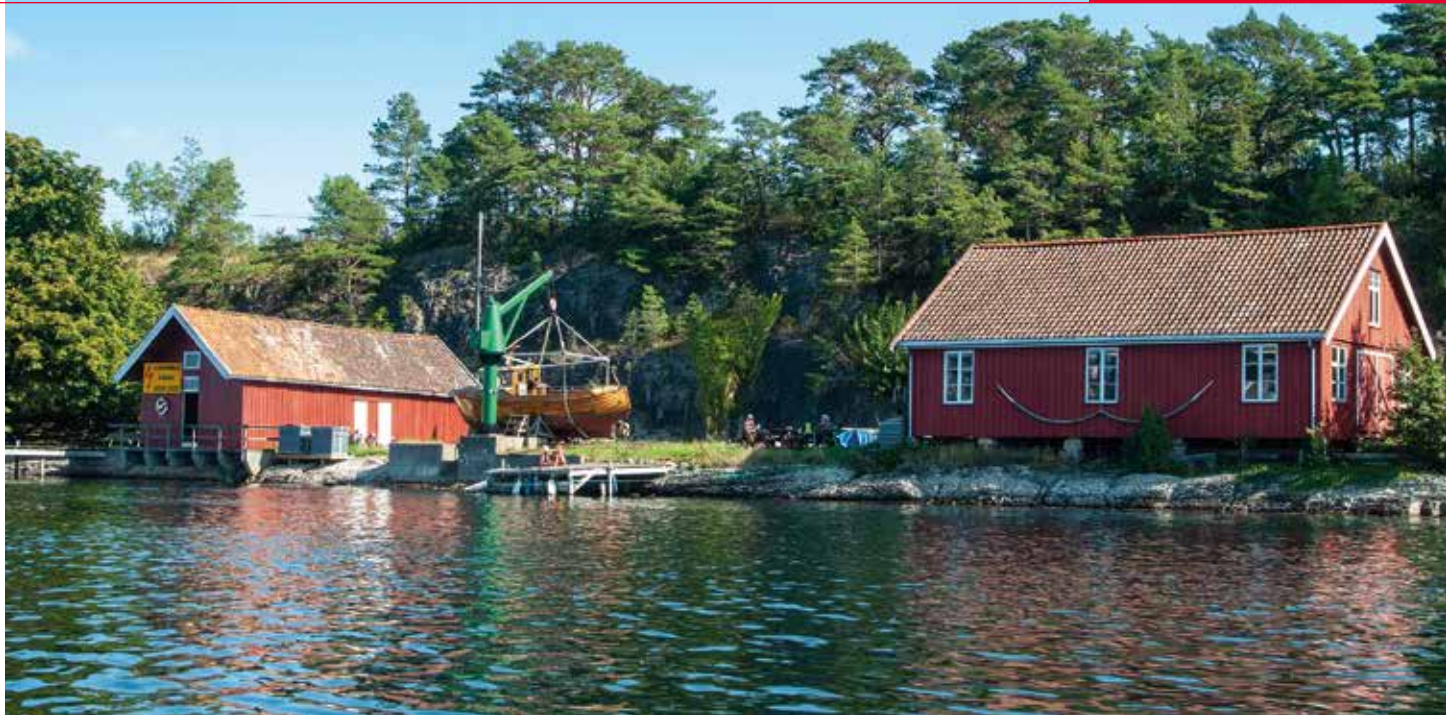
Båtbyggeriet på Langøya er satt i stand slik at det kan bygges og vedlikeholdes båter der.
