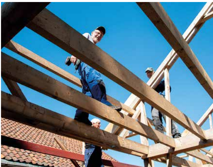
Dugnadsgjengen er godt i gang med å reise småbåtlageret til kystlaget.
