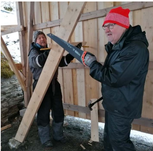
Bjarne og Bård bygger trapp opp til loftet
