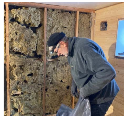
Kåre rydder vekk gammel isolasjon
