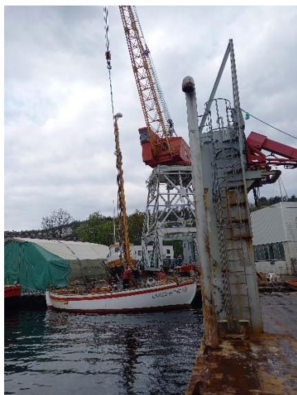
Montering av mast
